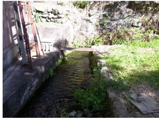
隣地 (荒川製麺) 境にある水路
