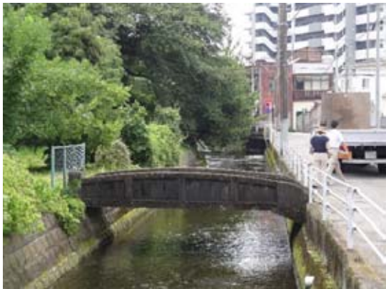
入口のレトロなコンクリート橋
