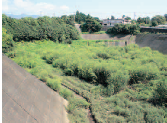
片倉雨水貯留池
