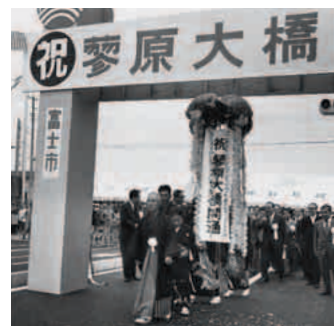
蓼原大橋開通(1977)
