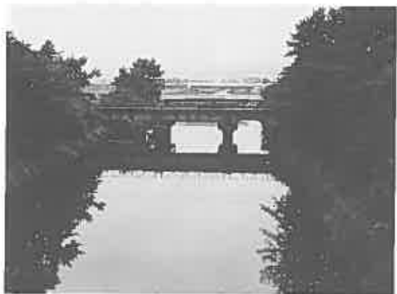
国道一号線から見た昭和放水路
