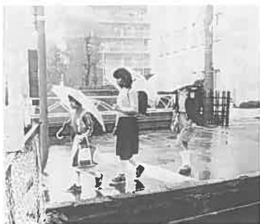
東京電力（平垣）横の「札の辻橋」
