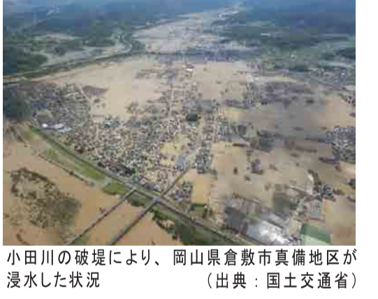
小田川の破壊により、岡山県倉敷市真備地区が浸水した状況 (出典:国土交通省)
