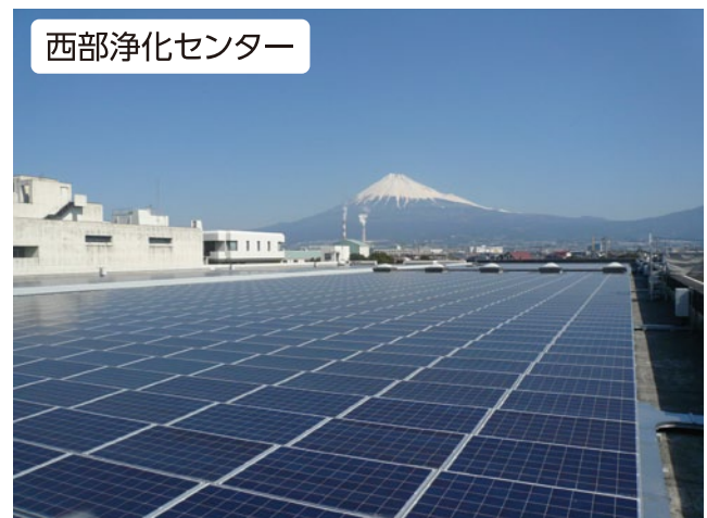
図 3-14 東部及び西部浄化センターの太陽光発電
