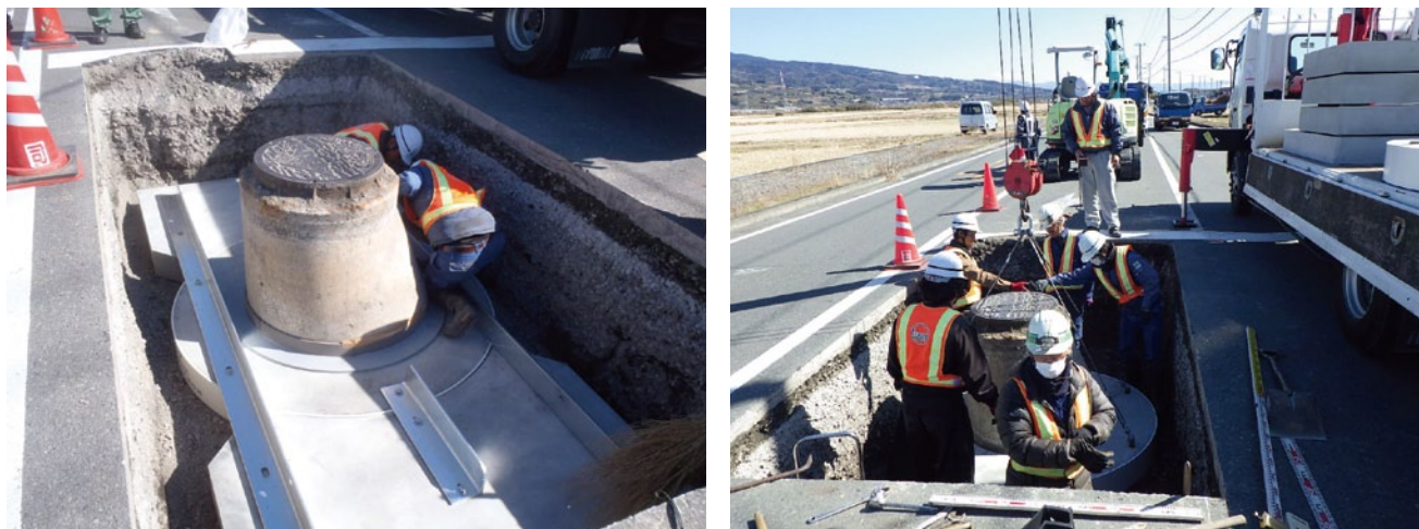
図 3-16 マンホール浮上防止工事
