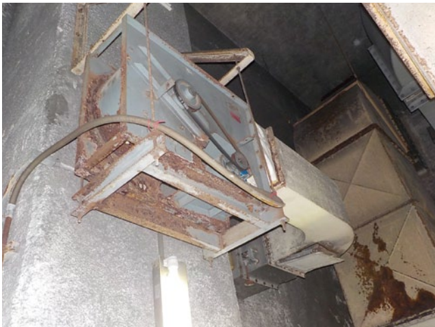
図 3-30 建築附帯設備と機械設備の腐食状況(西部浄化センター)
