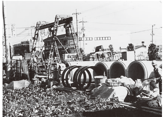
図 2-2 下水道管路新設工事(昭和50年代)
