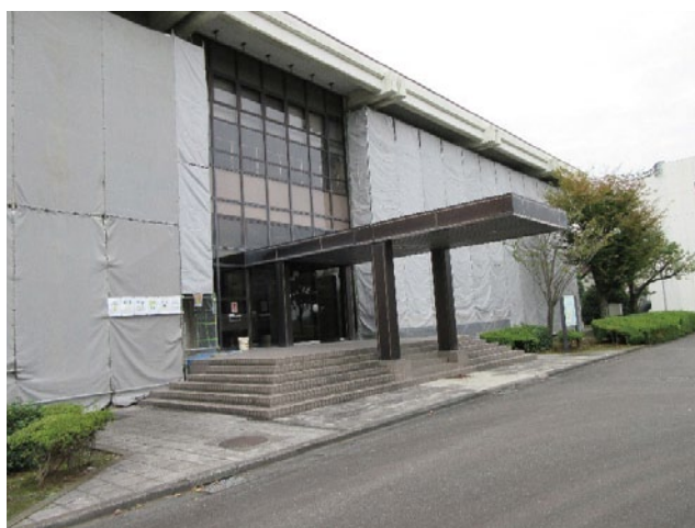
図 3-17 東部浄化センター沈砂池管理棟の耐震化
