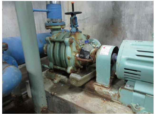
図 3-30 建築附帯設備と機械設備の腐食状況(西部浄化センター)
