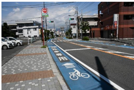
県道鷹岡富士停車場線(富士駅付近)
