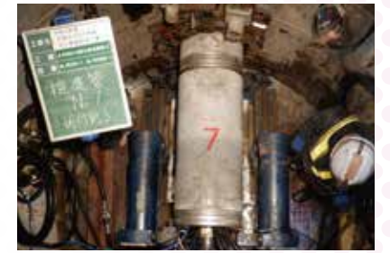
下水道管設置状況
