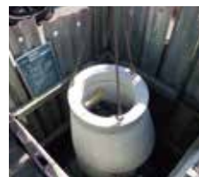
マンホール設置状況
