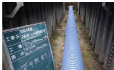
下水道管設置状況
