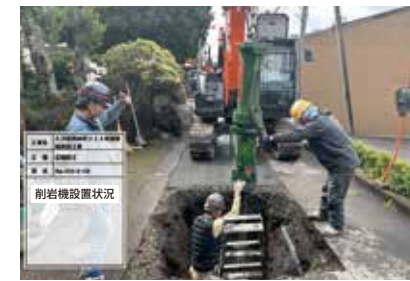
削岩機設置状況
