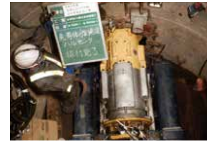
推進機設置状況
