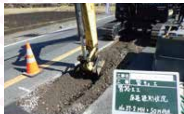
掘削状況(開削工法)
