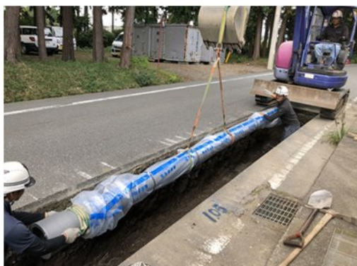
図 3-12 布設替工事
