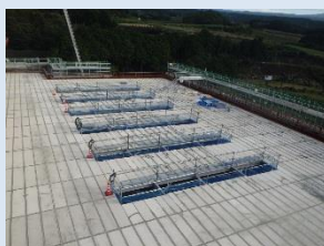
A L C屋根施工状況
