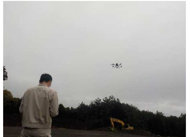
ドローンによる現場確認
