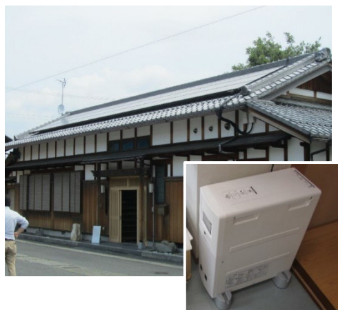
図 4-17 公会堂への先進的設備の導入事例 （出典：長浜市 HP「ながはま絆発電。」 五村自治会）
