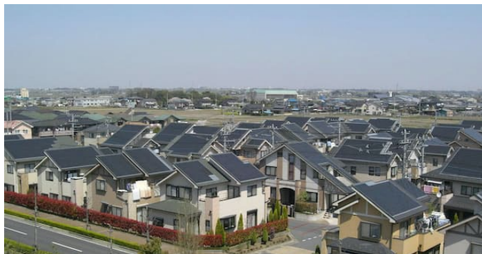
図 4-10 住宅への太陽光発電設備設置の様子 (出典：日本経済新聞社)
