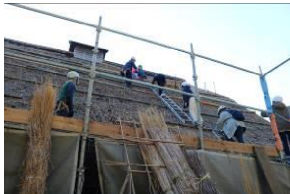
茅葺き屋根の葺き替え見学会
