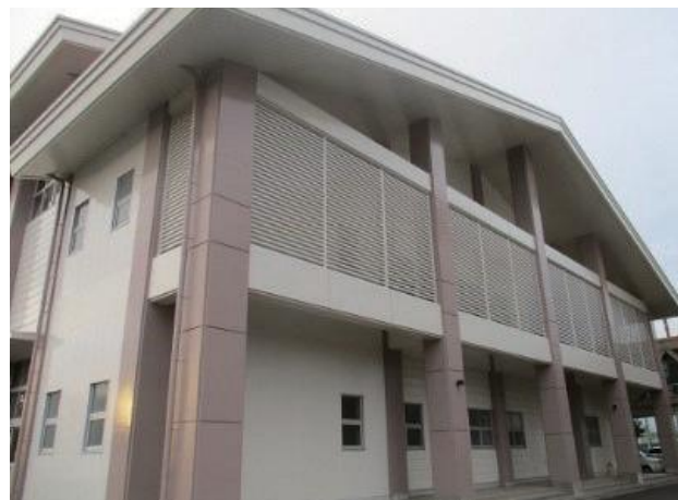
体育館の外壁改修
