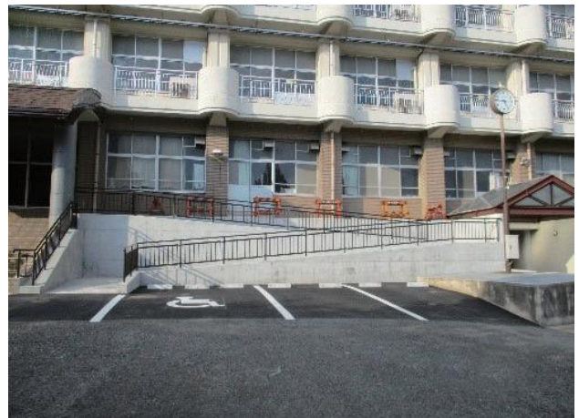
バリアフリー改修
