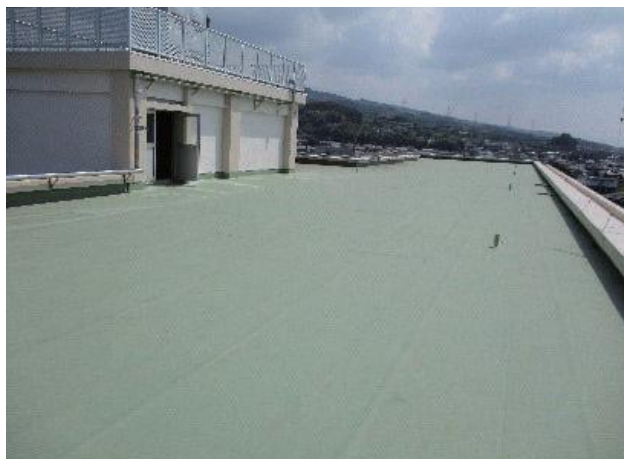
屋上の防水改修
