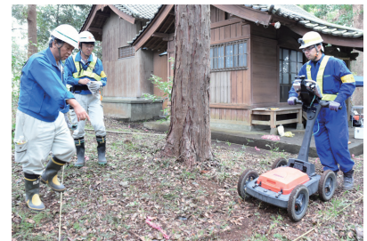
測定機器を走行させ地中レーダー探査を行う
