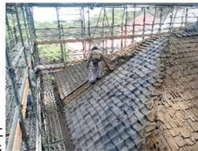
▲瓦屋根の解体
