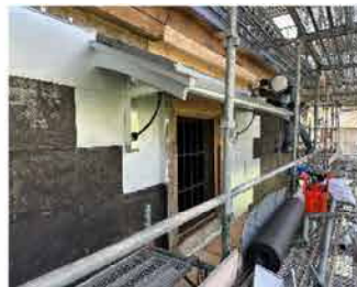
外壁鉄板葺き
