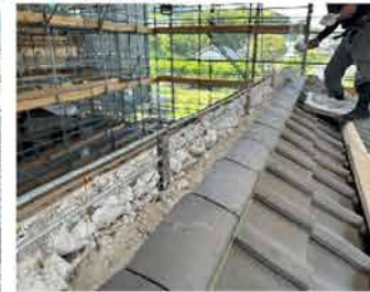
耐震棟の設置
