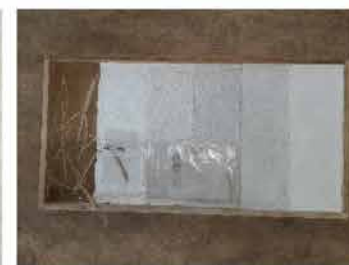
板蔵 塗り壁工程
