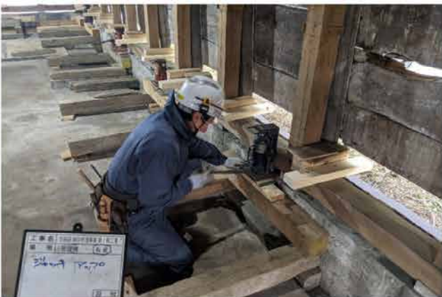
ジャッキアップの様子
