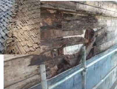
▼外部鉄板の解体
