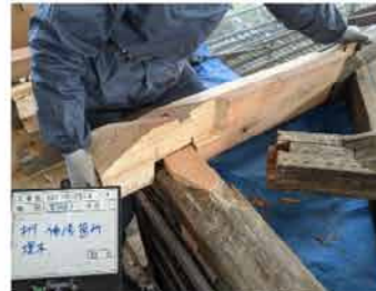
けた 桁の腐朽部分の補修
