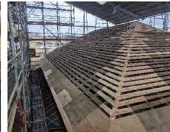
屋根下地の補修
