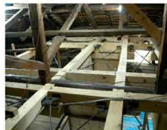
小屋裏水平補強
