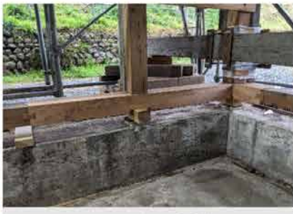
土台 継木補修
