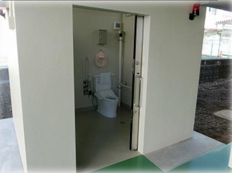
西北の角に、多目的トイレが設置されました。ユニバーサルデザインがコンセプトです。
