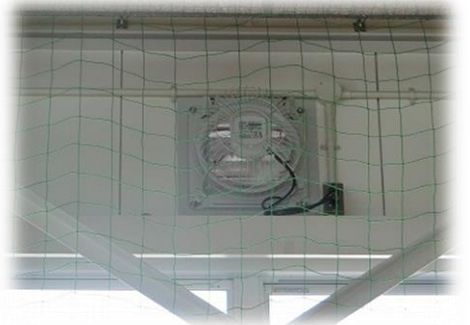
東西の内側の壁のたかいところに8か所換気扇が付きました。雨の日も安心です。
