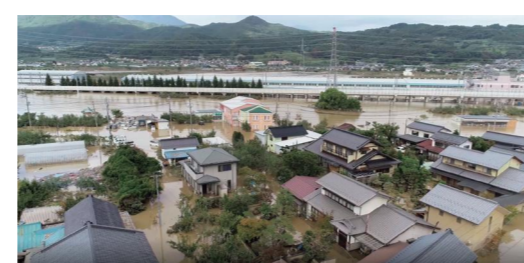
Situação na qual o local de Akunuma, cidade de Nagano, foi inundado devido à ruptura do rio Chikuma (Fonte: Autoridade de Informação Geoespacial do Japão)
