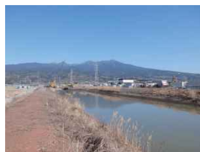
江尾江川の改修
