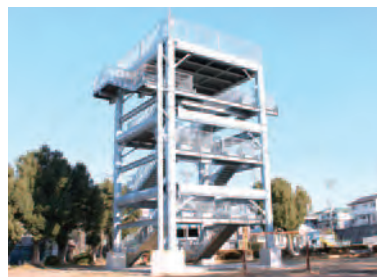
津波避難タワー
