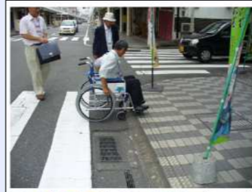
・誘導ブロックとマンホールの位置が重なっている。 →誘導ブロックをずらして設置する。
