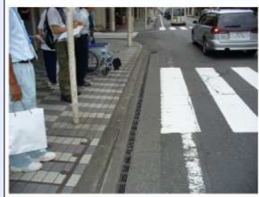
・誘導ブロック（点状ブロック）が横断歩道の幅に満たない。 →横断歩道幅員分で設置する。
