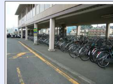
・歩道の段差 ・スロープなし → スロープの設置
