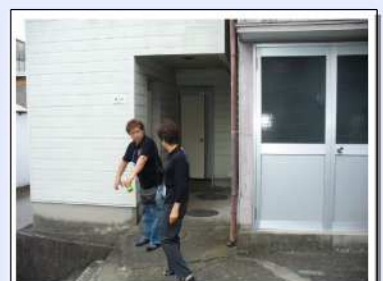
トイレの入口が分からない。雨の日に滑りやすい。 → 手すり、車椅子対応とする。
