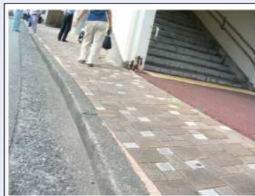
・階段下に誘導ブロックがない。 → 誘導ブロックの設置
