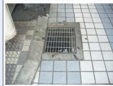
・グレーチングの目が粗い。 →目の細かいグレーチングに交換する。
