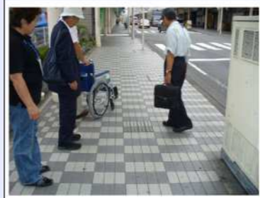
・誘導ブロックが連続設置されていない。 →連続して設置する。
