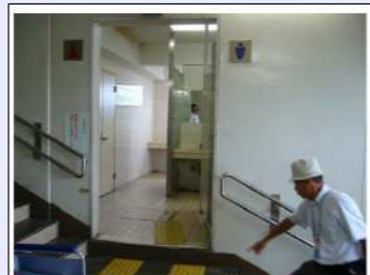
・階段途中のトイレ（位置、段差など） → 階段の上または下への移設。
