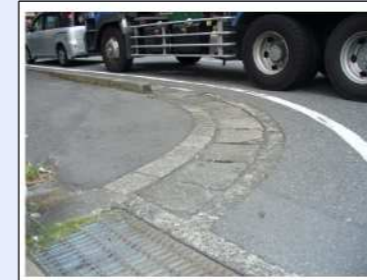
・側溝の蓋の穴が大きい、グレーチングの目が粗い。 →蓋の穴をもっと小さく、目の細かいグレーチングに変更。
