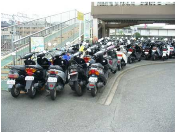
原動機付自転車によりふさがれた通路 (改善前)
