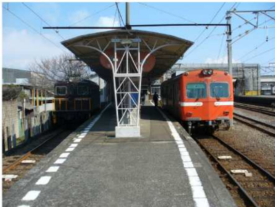
現在の岳南鉄道吉原駅プラットホーム
