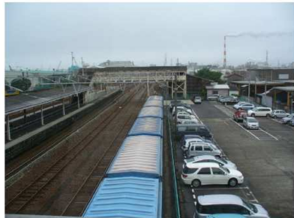
新規連絡通路設置予定箇所（中央フェンス右側）
