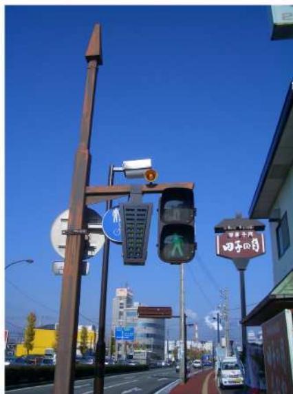
バリアフリー対応型信号機設置のイメージ（JR新富士駅周辺） ※静岡県公安委員会の単独事業として設置される可能性がある。
