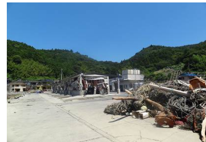
津波により被災した漁港施設
