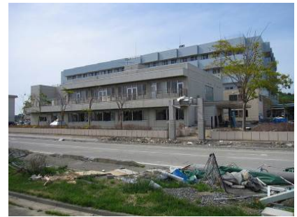
津波により被災した病院施設
