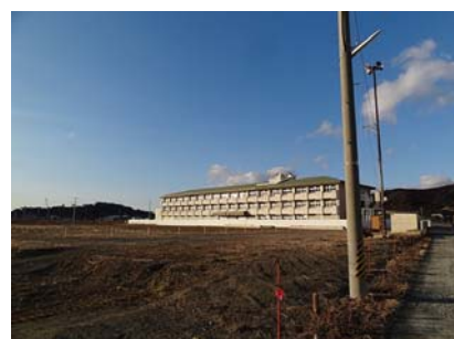
工事が遅れている復興事業用地
