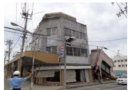
地震により被災した商店街
