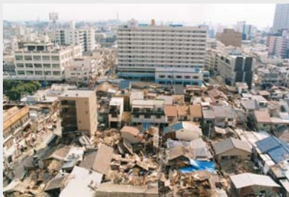
住宅被害 (神戸市)
