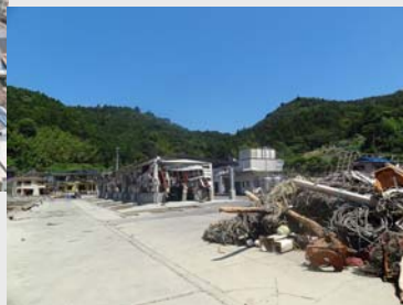
漁業施設 (石巻市)
