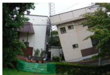
▲建物倒壊 【北海道胆振東部地震/札幌市】
