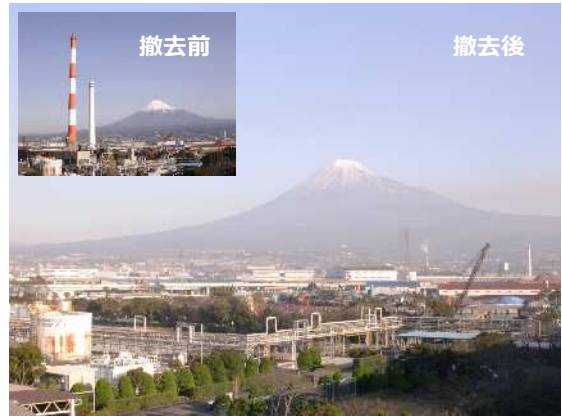
煙突撤去前後の景観
