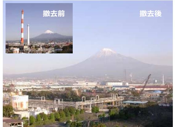
煙突撤去前後の景観
