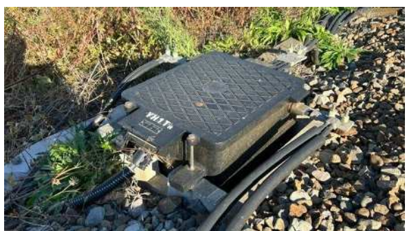
●インピーダンスボンド更新工事（吉原駅）
