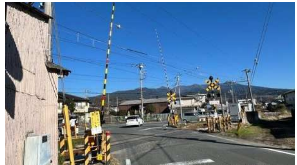
●踏切更新工事（富士岡県道踏切）
