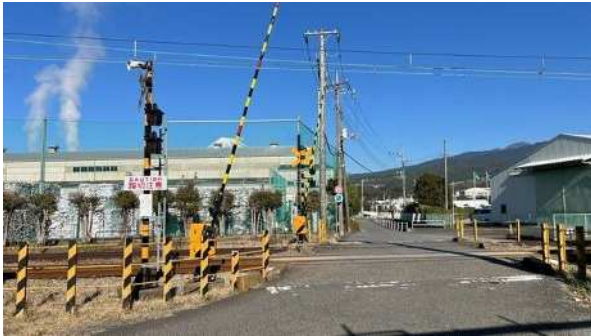
●踏切遮断機・警報機更新工事（荒川踏切）
