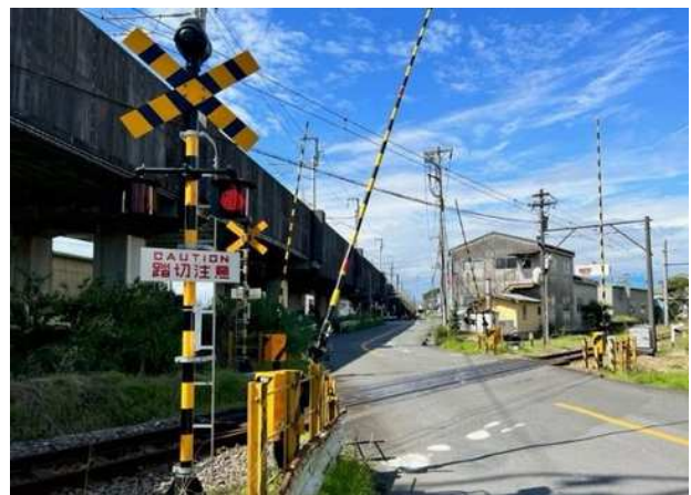
●踏切遮断機、警報機更新（江尾公団踏切）
