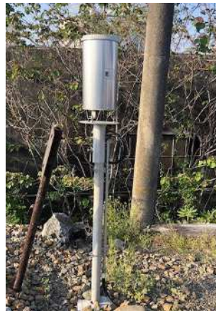
●雨量計設置工事（吉原駅）
