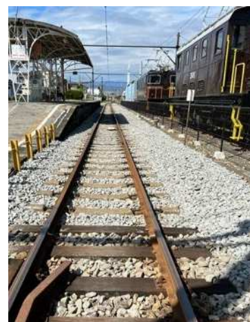
●木まくら木の PC まくら木化工事（岳南富士岡下り本線）
