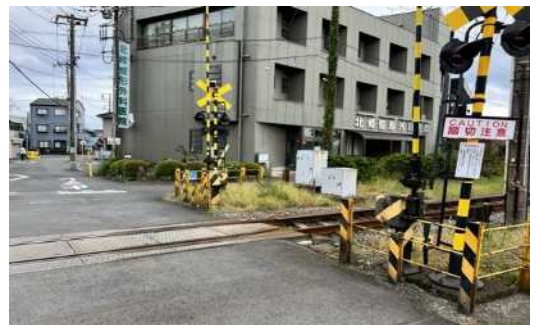
踏切 本町南踏切
