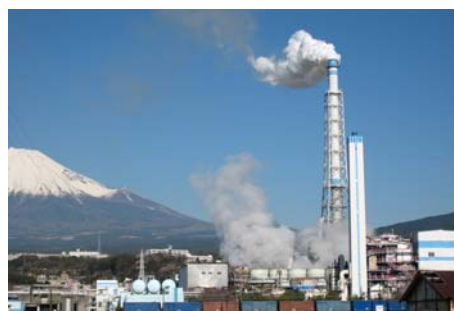
塗替後（中光度白色航空障害灯設置）
