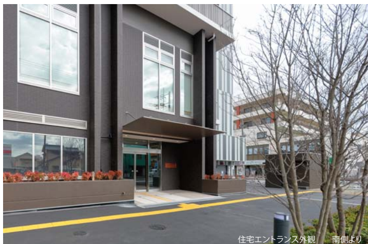
住宅エントランス外観 南側より
