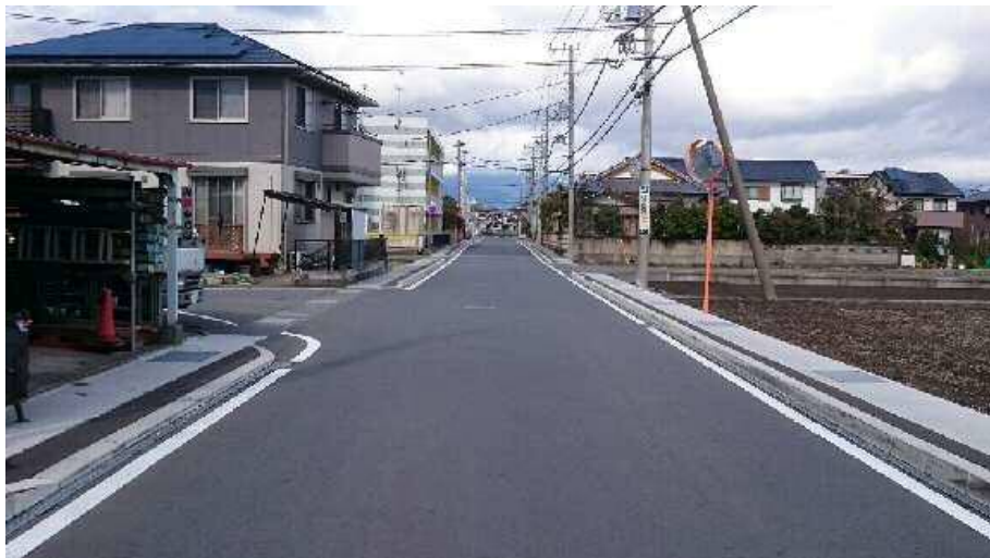
【完成写真】 矢印の方向から撮影
