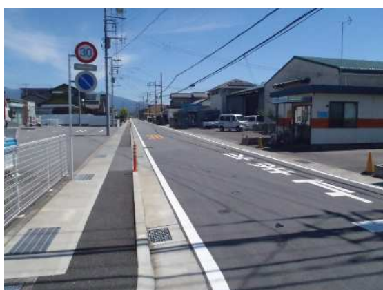
【完成写真①】矢印の方向から撮影
