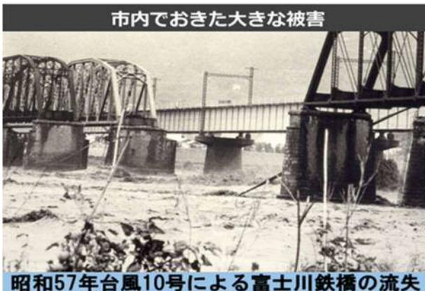
写真は、昭和57年台風10号による富士川鉄橋の流失の様子です。
