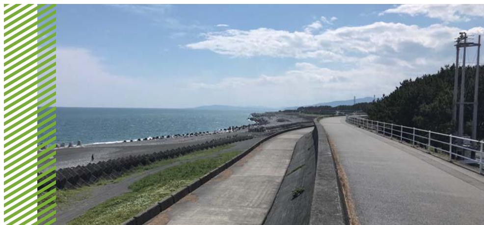
海岸線約 10km に渡る、海拔 17m の防潮堤（富士海岸）
