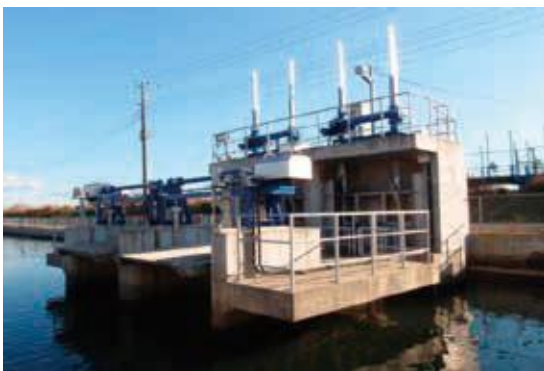
江尾江川地区西側排水機場
