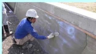
老朽化した水路壁のコーティング
