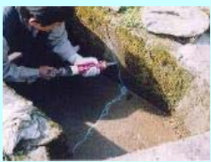
水路のひび割れ補修
