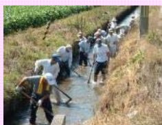
水路の泥上げ
