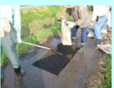
農道の部分補修
