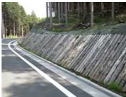
利用事例(丸太伏工：現場発生材利用)
