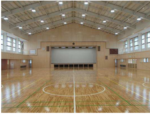
内装木質化事例(富士川第一小学校体育館)
