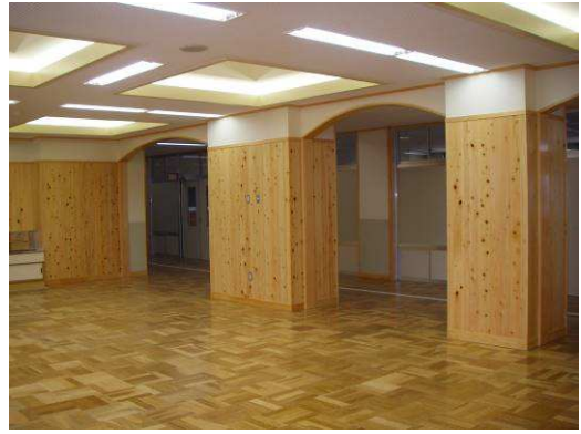
内装木質化事例(丘小学校校舎)
