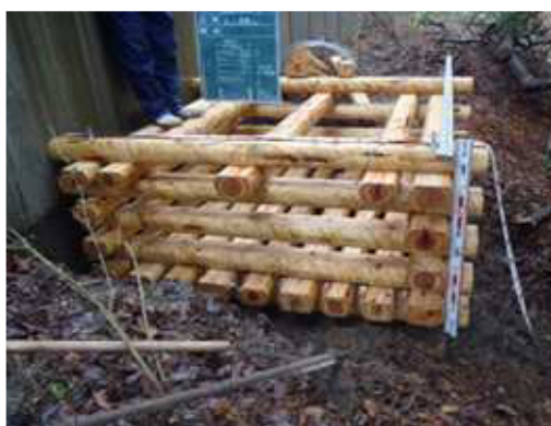
利用事例(木製沈床工)
