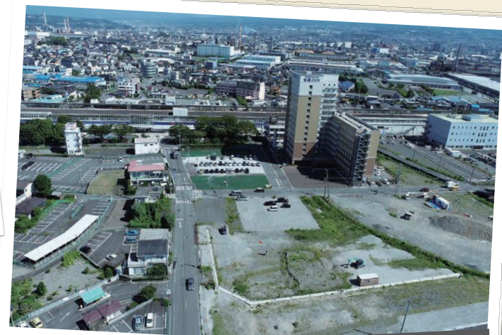
区画整理が進む新富士駅南地区
