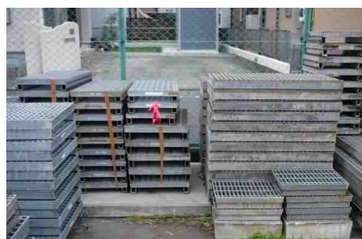
側溝用グレーチング蓋（1枚約2万円） を再利用し、工事費を削減!!
