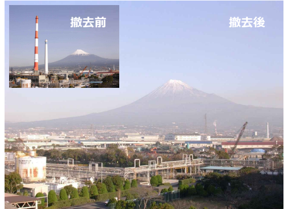
煙突撤去前後の景観
