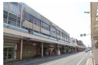
[吉原商店街の防災建築街区]
