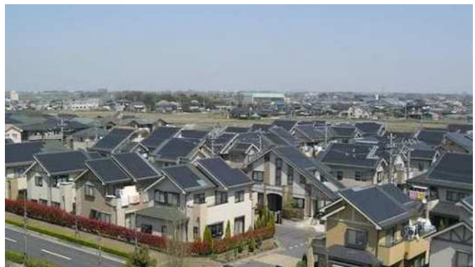
図 7-1 太陽光発電設備を備えた住宅地 (出典：日本経済新聞社)
